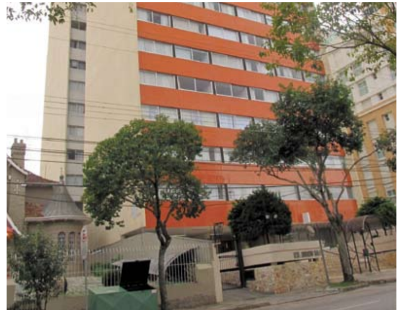
Edifício Orion, em Curitiba: reforma geral na estrutura elétrica
