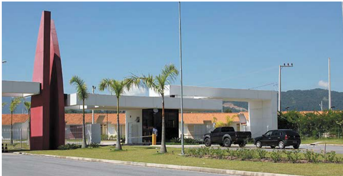
O Condomínio Terra Nova Palhoça possui 1274 casas e vias internas com intenso tráfego de veículos
