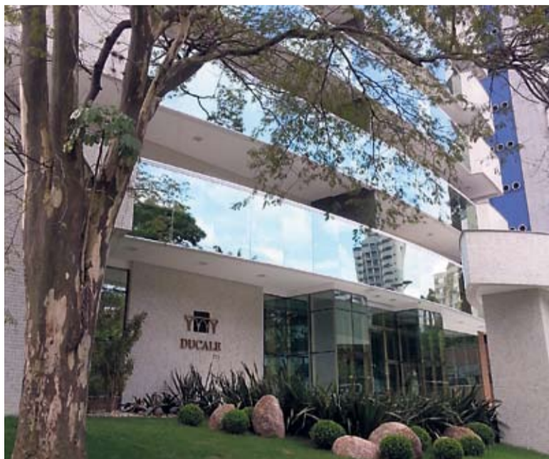
Residencial Ducale já está pronto para receber os novos moradores
