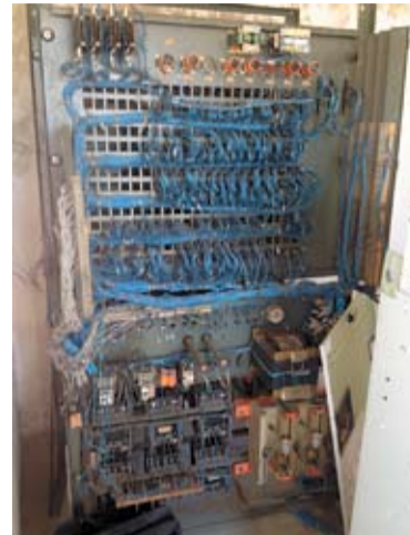
O quadro de comandos do elevador antes e depois da reforma
