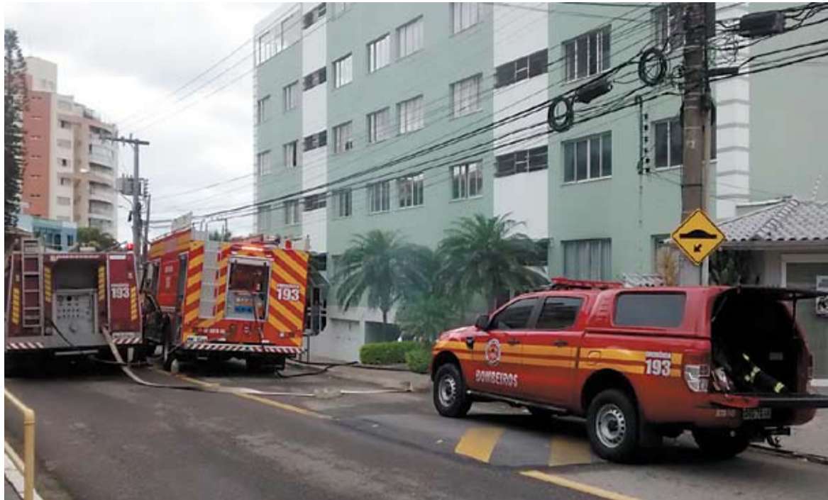
O incêndio de um veículo no edifício Maria Aparecida causou estragos na garagem e corredores do condomínio
