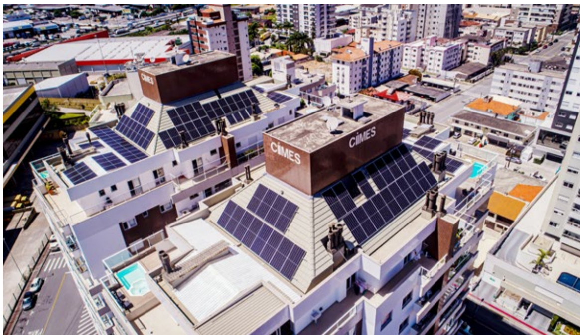
NO RESIDENCIAL TORRES DEL PAINE foram instalados 144 placas fotovoltaicas divididas entre os dois blocos
