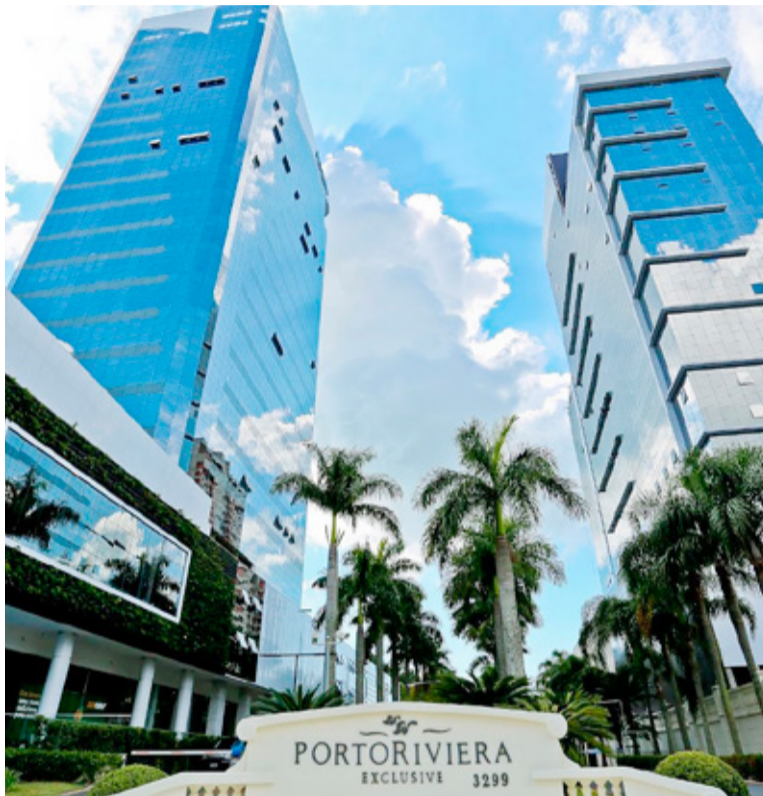
COMPLEXO MULTIUSO RIVIERA CONCEPT: unidades comerciais, residenciais e hotelaria na Praia Brava, em Itajaí
