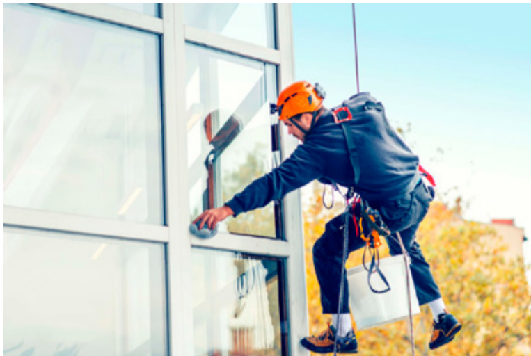
A LIMPEZA de vidros externos de edifícios realizada acima de dois metros de altura exige qualificação técnica
