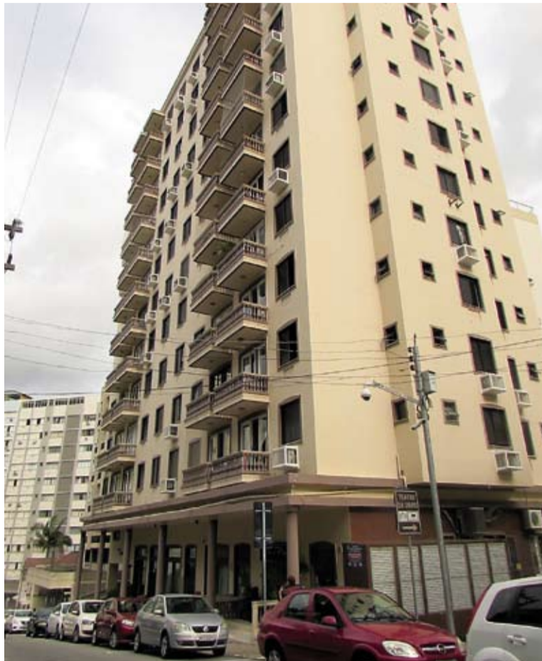
O condomínio Solar das Acácias optou pelo sistema de individualização dos hidrômetros em 2010
