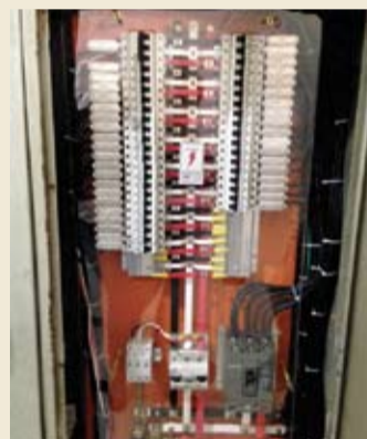
Quadro elétrico depois da reforma
