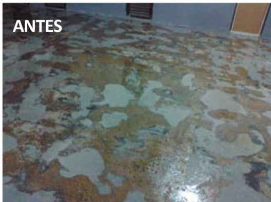
Garagem do Condomínio Renoir: revitalização do piso com revestimento epóxi de 2 milímetros
