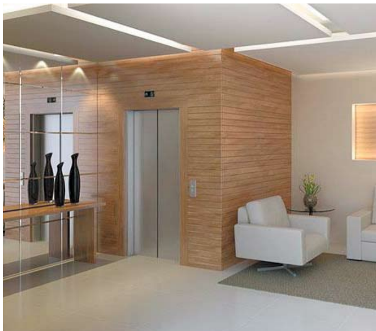
Drywall no hall de entrada: teto rebaixado para potencializar a iluminação
