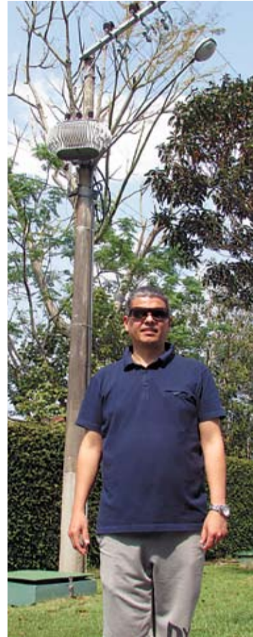
Síndico do condomínio Residencial Central Park, Robson de Oliveira Soares providenciou a troca do transformador que estava há 15 anos sem manutenção
